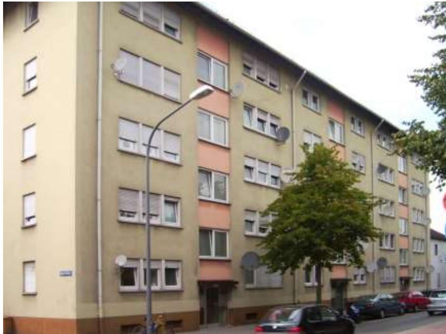
Abbildung 8: Deutsche Straße 19-23 als Beispiel für "mittleren Sanierungsbedarf"
