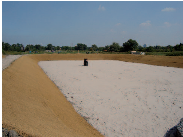
Bodenfilter vor der Bepflanzung
