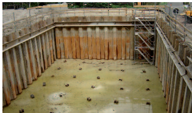
Baugrube des Pumpwerks
