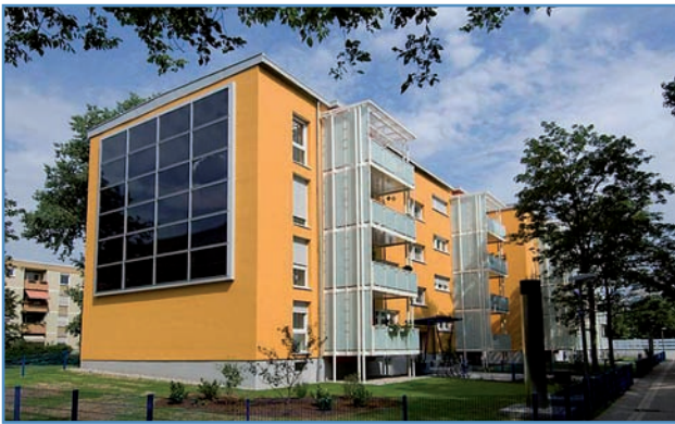
Null-Heizkosten-Haus der LUWOG E GmbH
