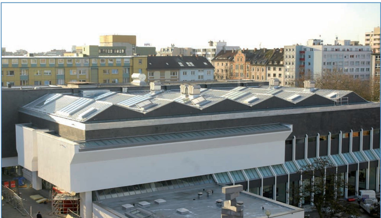
Photovoltaikanlage auf dem Dach des Wilhelm-Hack-Museums
