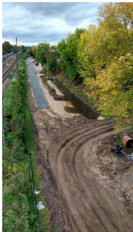
Polder Notwende-Altrheingraben im Bau, Oktober 2019 (Foto: Stadt Ludwigshafen, Bereich Umwelt)
