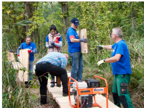
Bau eines Stegs im Maudacher Bruch beim Freiwillingentag 2018 (Foto: Stadt Ludwigshafen, Bereich Umwelt)
