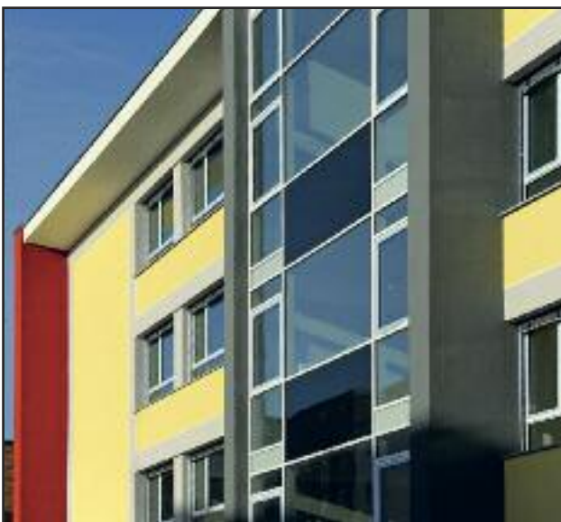
Die sanierte Fassade der Erich Kästner-Schule erstrahlt wieder in den Originalfarben
