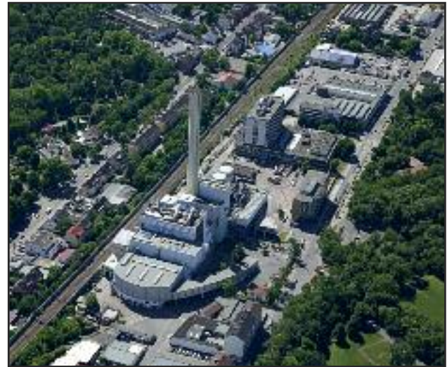
Vorne das Müllheizkraftwerk der GML mit dem direkt dahinter anschließenden Fernheizkraftwerk von TWL
