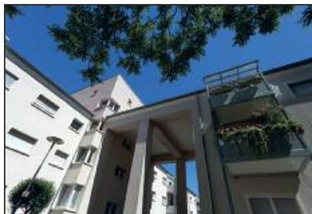
Denkmalgeschützte Ebertsiedlung: Energetische Sanierung im Bestand
