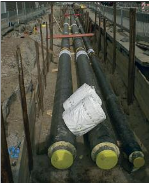
Fernwärmerohre werden meist unterirdisch verlegt
