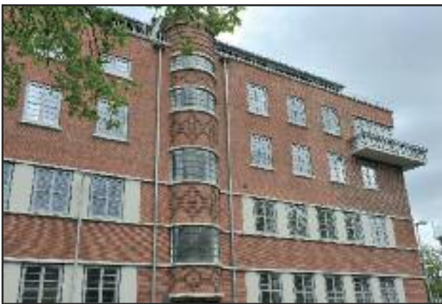
Stadtquartier Lutherstraße: Energetische Sanierung eines denkmalgeschützten Gebäudekomplexes
