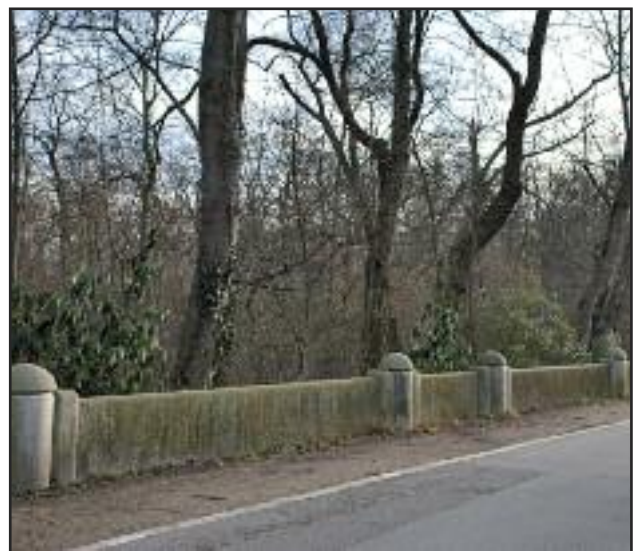
Hochwasserwand als Freibordschutz auf der Parkinsel
