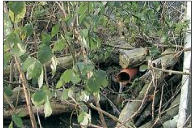
Einleitung von Niederschlagswasser in einen Graben
