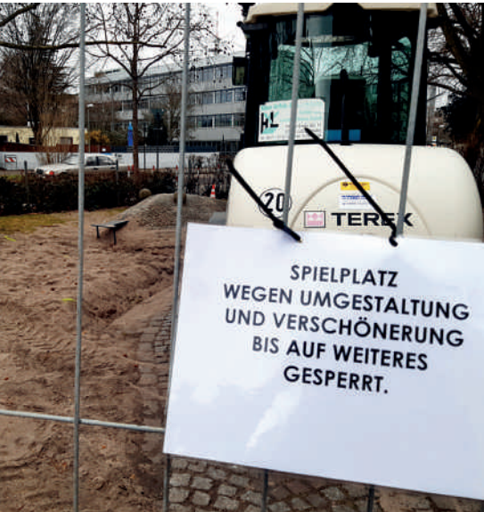
→ Die Baustelle auf dem Spielplatz in der Walkürenstraße im März.
