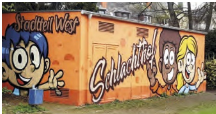
→ Das mit Graffiti verschönerte Trafohäuschen am Rudolf-Hoffmann-Platz in West.
