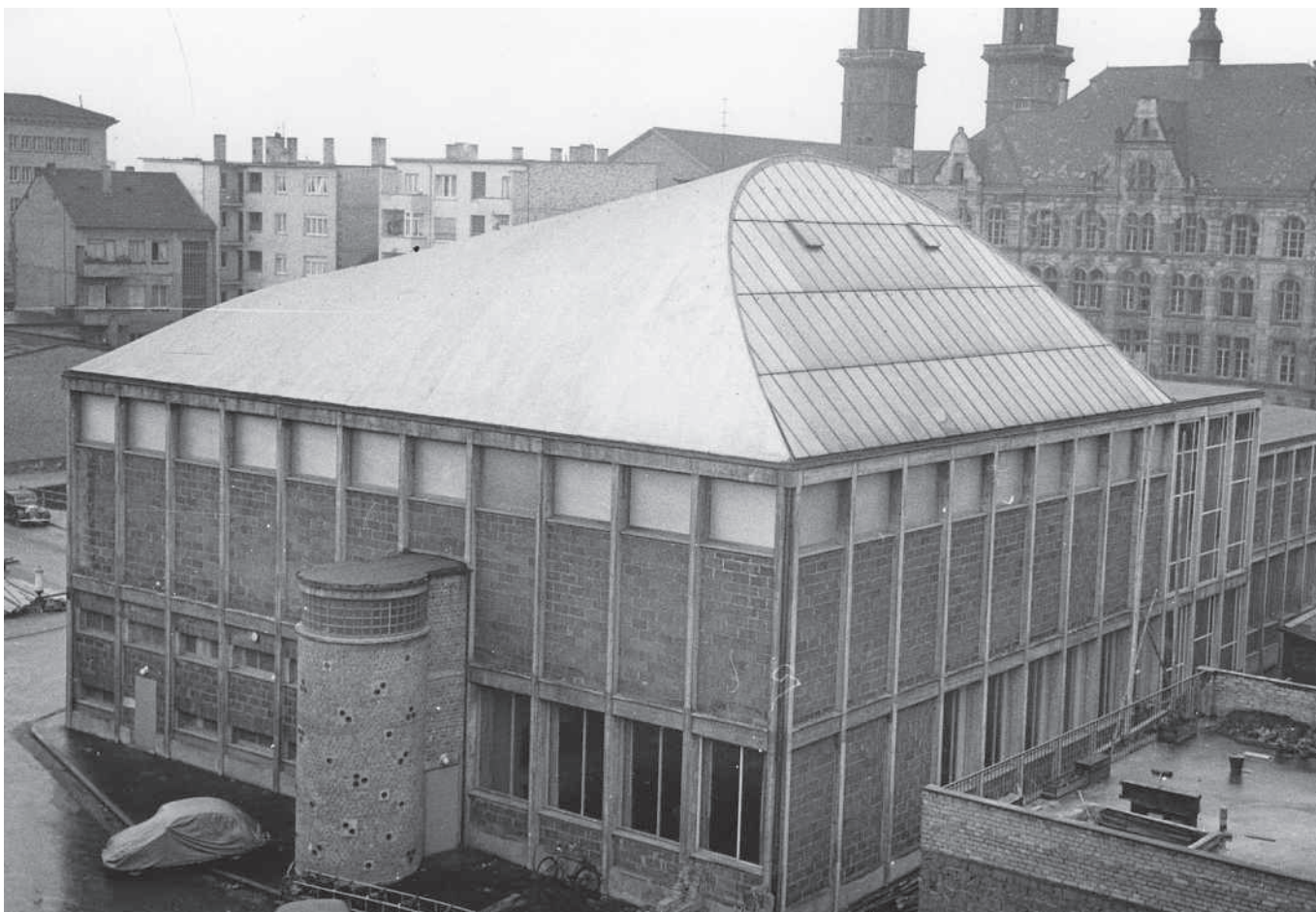
→ Das neu gebaute Bürgermeister-Ludwig-Reichert-Haus im Oktober 1956.
