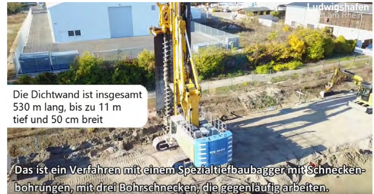
Screenshot aus dem Video zur Grundwassersanierung Frigenstraße
