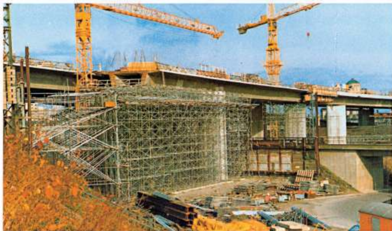
Eingeschalte Auffahrtsrampe vom Grünzweigknoten zur A 650 über der Lorient-Allee und Straßenbahn (oben links). Lehrgerüst zwischen den Dammstrecken und der Bundesbahngleise (links). Lehrgerüste für die Haupttrichtungsfahrbahn zur A 650 vor der Lorient-Allee (oben)
