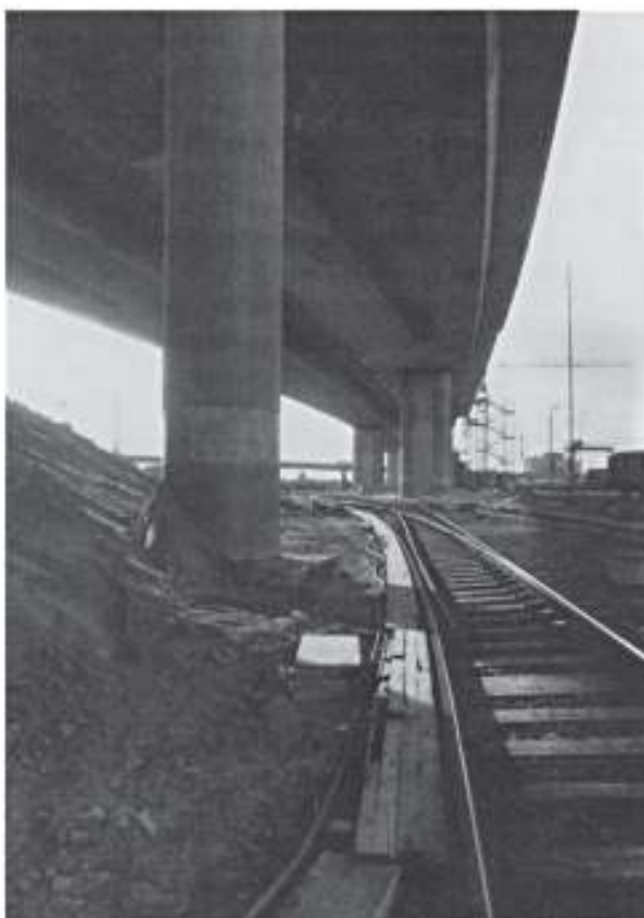
Hochstraße – II. Bauabschnitt im Bereich des Güterbahnhofes.
