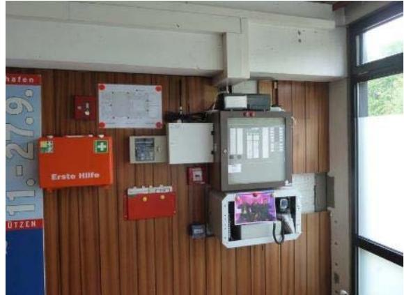
Abb. 300: Brandmeldezentrale mit Feuerwehrbedienfeld und Laufkarten
