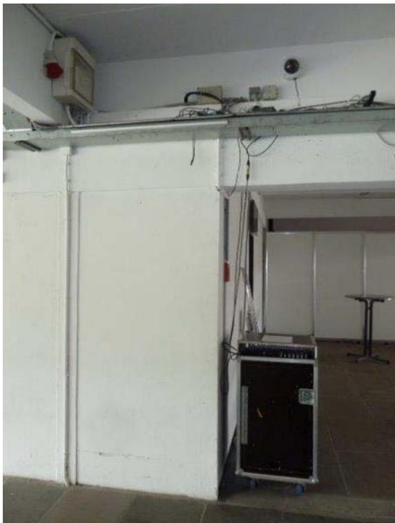
Abb. 305: Offene Kabelinstallation Daten-, Fernmeldetechnik im Foyer
