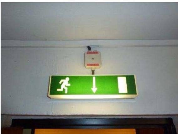
Abb. 288: Sicherheitsbeleuchtung ohne Funktionserhaltkabel
