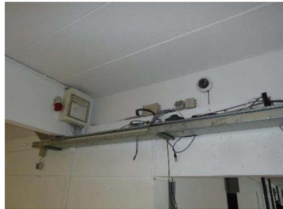
Abb. 293: Offene Elektroinstallation auf Trasse mit Kabelbündeln im Foyer
