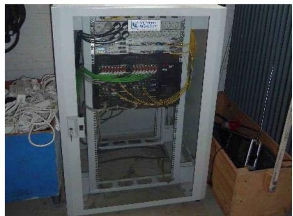
Abb. 306: Datenverteiler MTI für Veranstaltungen im Werkstattbereich
