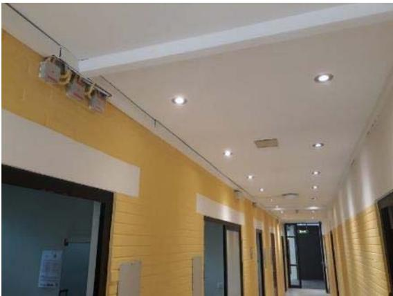
Abb. 286: Elektroinstallation mit Kunststoffkanälen / Beleuchtung NV-Downlights in Fluren Nebenräume / Umkleide
