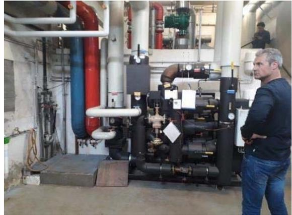
Abb. 261: Fernwärmeversorgungs-Station (FWV)
