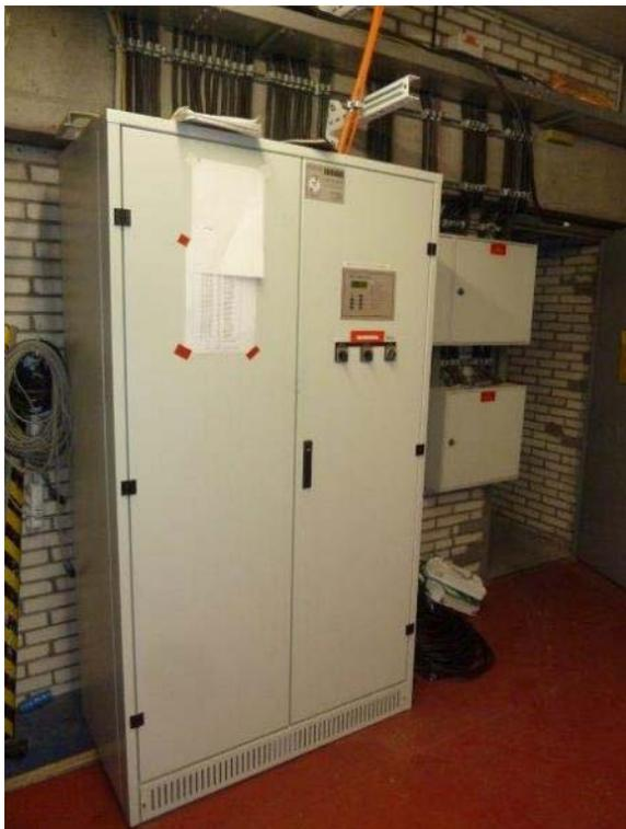
Abb. 296: Hauptverteiler Sicherheitsbeleuchtung im Raum mit Elektrohauptverteiler
