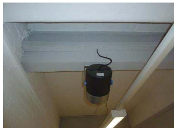
Abb. 302: Installation Alarmierung ohne Funktionserhalt und teilweise ohne 2-Linienaufteilung
