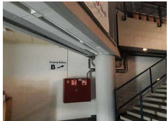
Abb. 253: Hydrantenanlage
