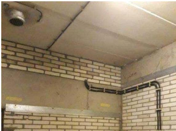
Abb. 281: Abluft Batterieraum ohne Zuluftanschluss
