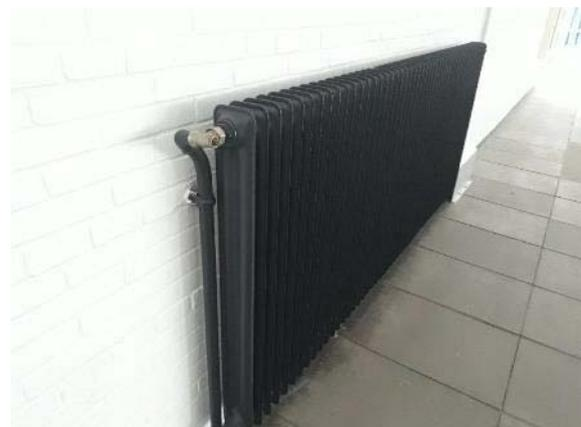
Abb. 266: HK teilweise beschädigt, ohne Thermostate
