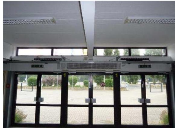
Abb. 268: Torluftschleieranlagen
