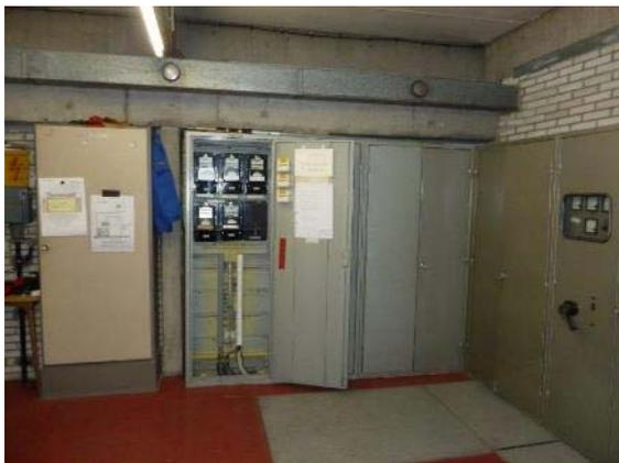
Abb. 277: Lüftungskanäle ohne Brandschutz
