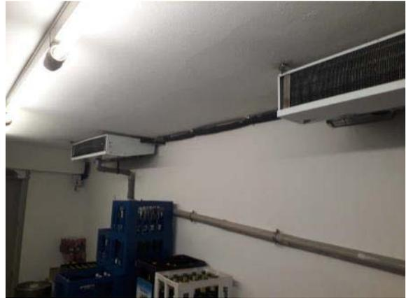
Abb. 273: Splitkälteanlage
