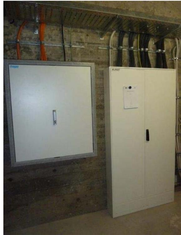
Abb. 299: Elektroverteilung und Unterstation Sicherheitsbeleuchtung für die Halle
