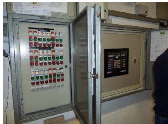
Abb. 289: Hallensteuerung (links unübersichtlich alt und rechts übersichtlich neu)
