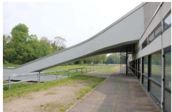
Abb. 245: Sanierte Widerlagerflügel (Spannbetonteile)
