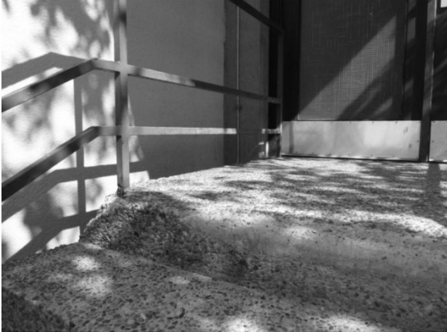
**Korrodierte Bewehrung, ausgebrochene Stufen, Eingangstreppe Bliessstraße 10**
