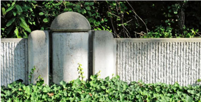
Die Höhe der Schutzeinrichtungen ergibt sich aus dem Bemessungshochwasser und der Freibordhöhe. Dem Schutzkonzept liegt eine Abflussmenge von 6000 m<sup>3</sup>/s am Pegel Worms zugrunde. Der Freibord richtet sich nach technischen Regelwerken und bedeutet einen Sicherheitszuschlag. Durch diesen muss das Überströmen der Schutzeinrichtungen infolge von Strömung, Wellenschlag, Brandung und ähnlichem verhindert werden.
