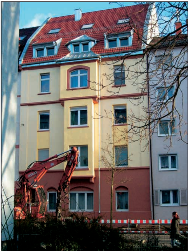
Valentin-Bauer-Straße 37 nach Modernisierung
