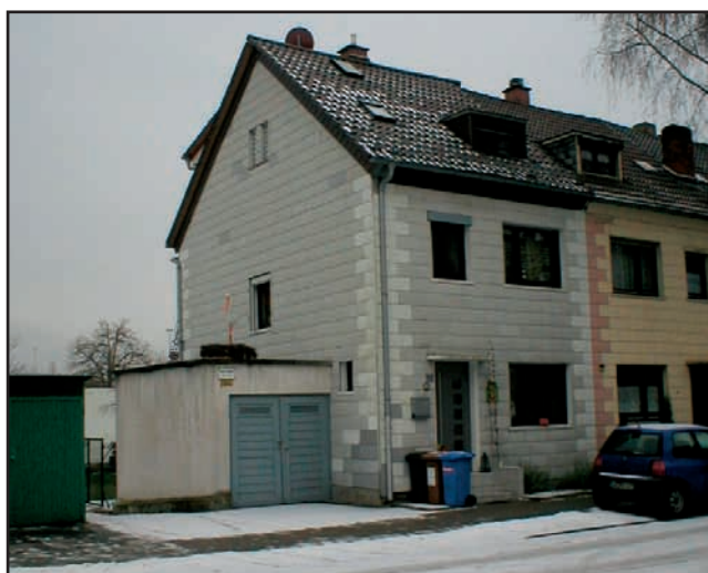
Gudrunstraße 17 vor Modernisierung
