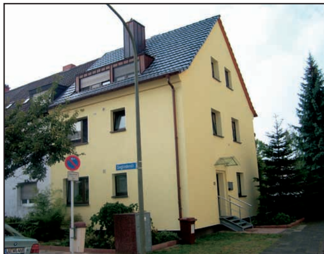
Sieglindenstraße 25 nach Modernisierung
