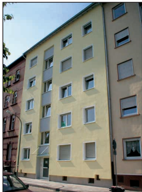
Gudrunstraße 8 nach Modernisierung
