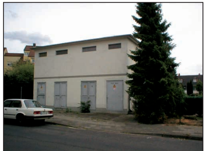
Trafostation Gudrunstraße 13 vor Sanierung und Umgestaltung
