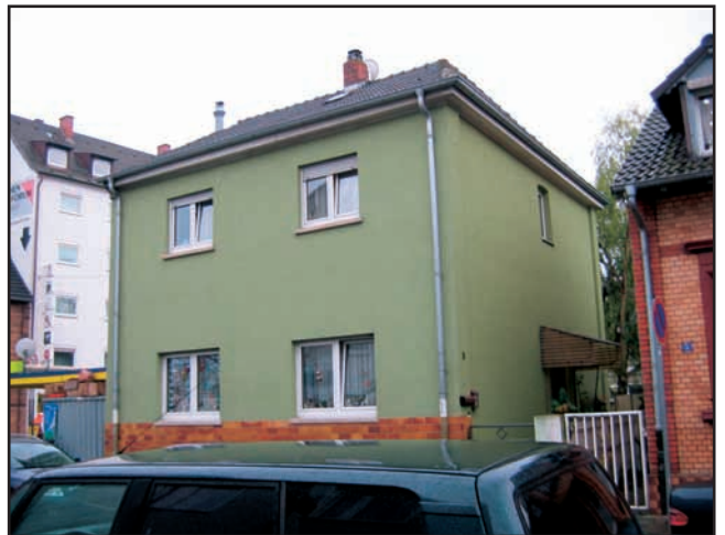
Alberichstraße 3 vor Modernisierung
