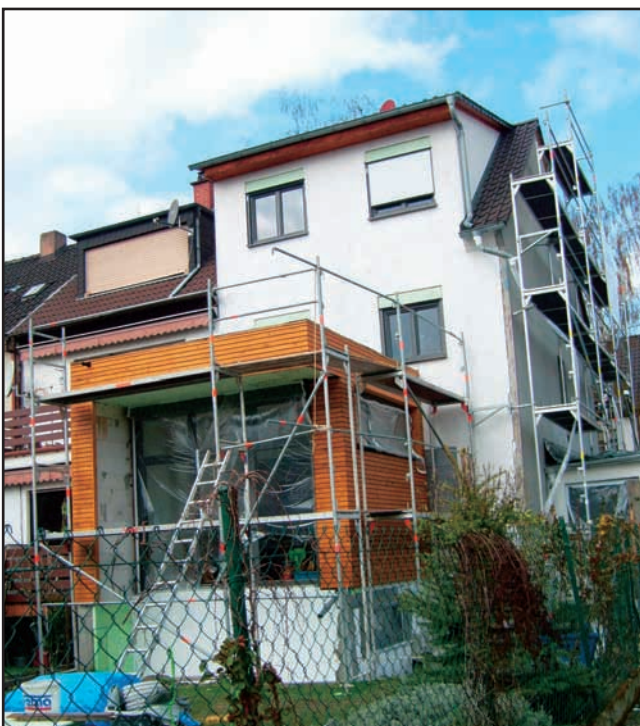
Gudrunstraße 17 während der Modernisierung
