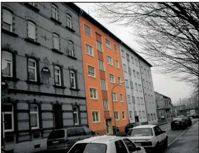
Gudrunstraße 8 vor Modernisierung
