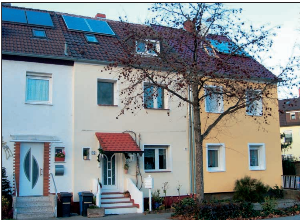
Freiastraße 27 und 25 nach Modernisierung
