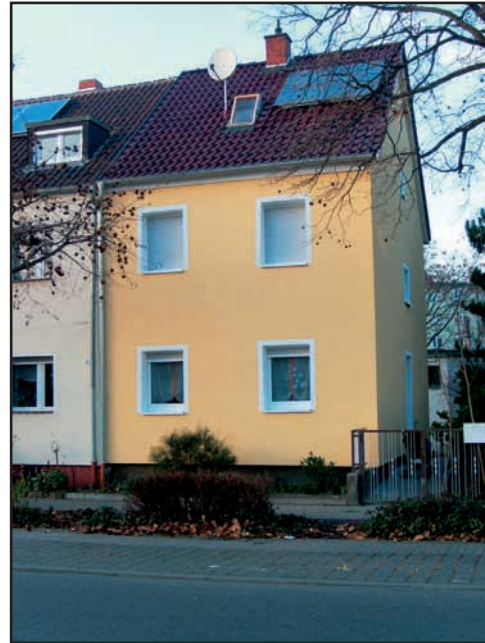
Freiastraße 25 nach Modernisierung
