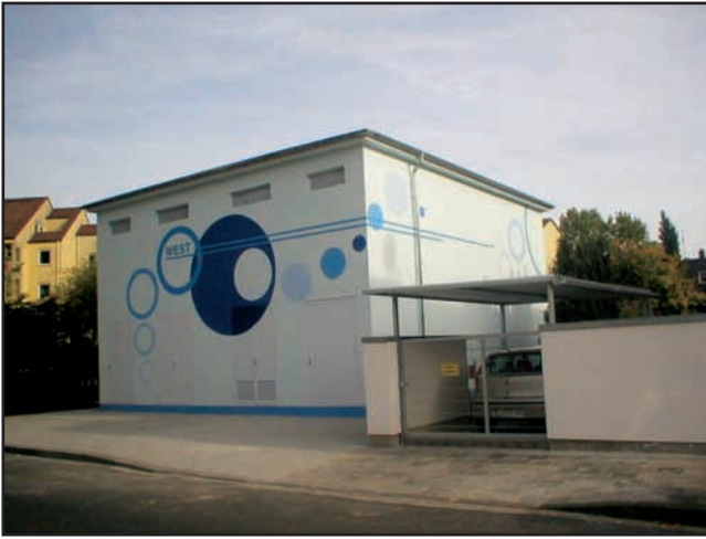
Trafostation nach Sanierung, Entwurf von Julia Korn
