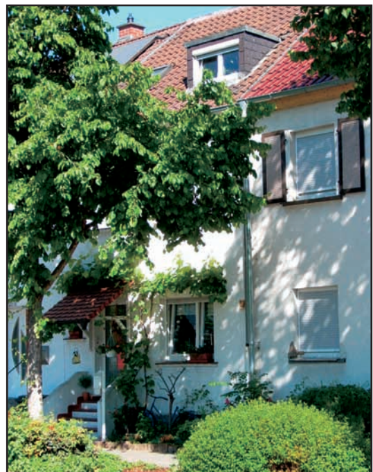
Freiastraße 27 vor Modernisierung
