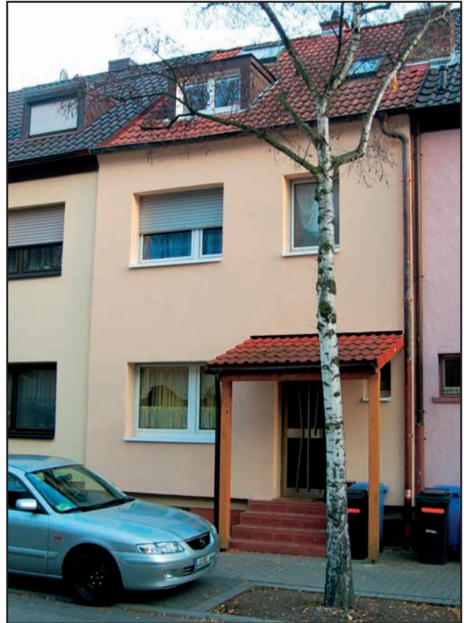
Gudrunstraße 31 nach Modernisierung
