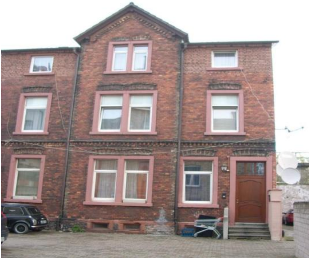
Abb. 6: Frankenthalerstraße 74 als Beispiel für „hohen Sanierungsbedarf“
