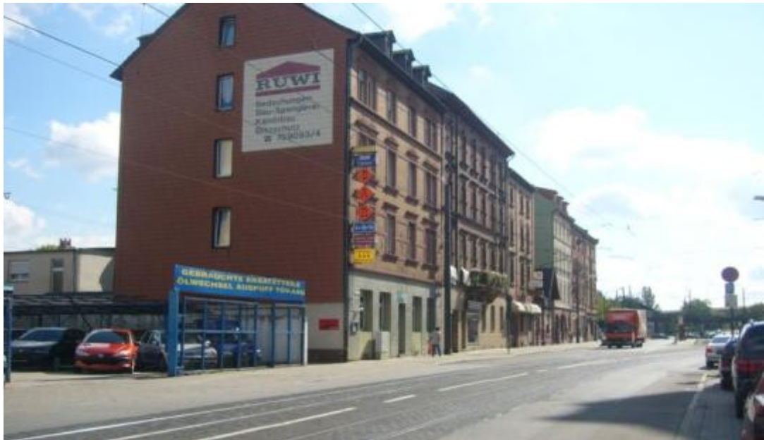
Abb. 13: Frankenthaler Straße mit Straßenbahntrasse
