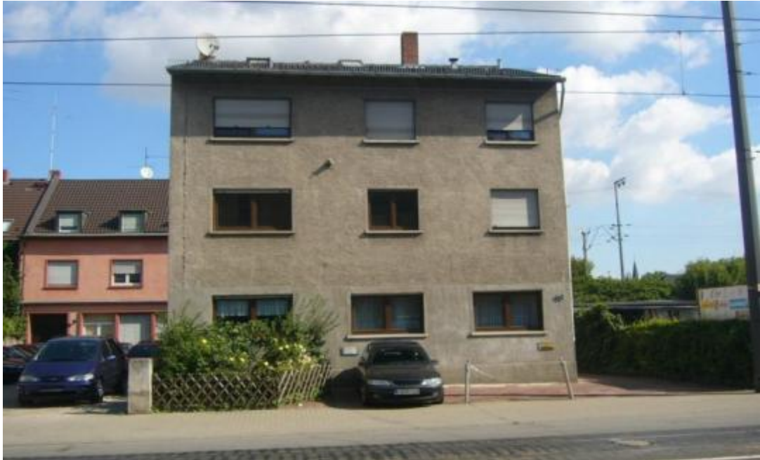
Abb. 5: Frankenthalerstraße 92 als Beispiel für „mittleren Sanierungsbedarf“
