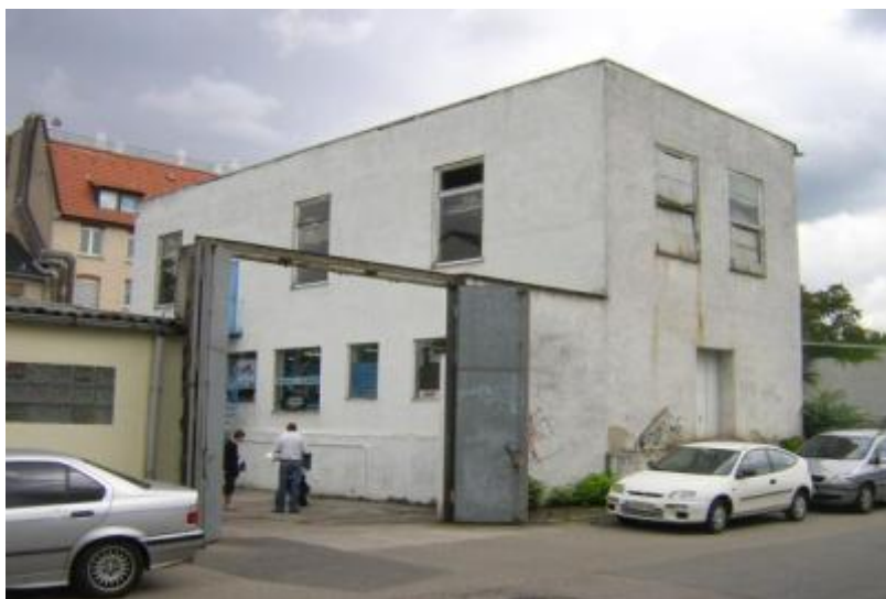
Abb. 12: Lagerplatzweg 6 als Beispiel für „Gebäude deren Substanz- und Nutzungswert gering ist“
