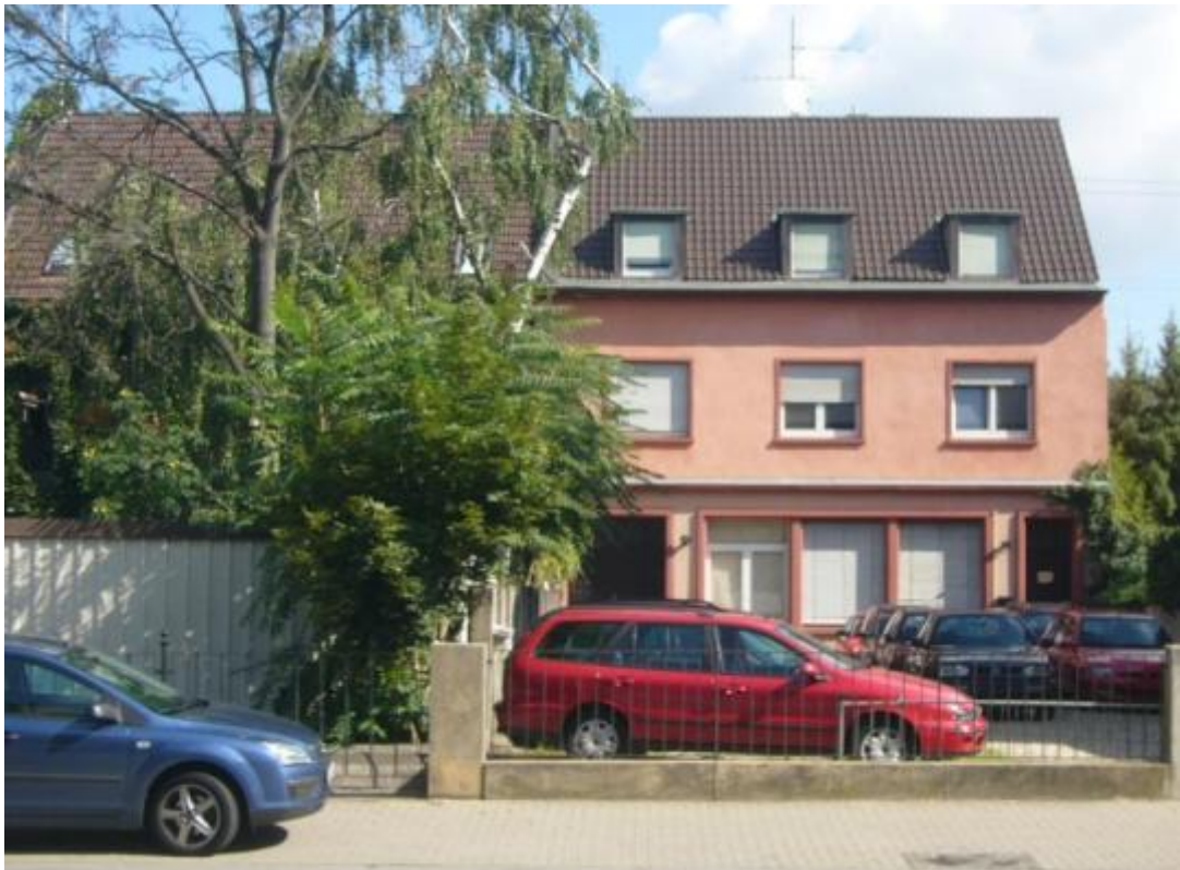
Abb. 10: Frankenthalerstraße 94 als Beispiel für „Gebäude mit Umnutzungspotential und Umnutzungsnotwendigkeit“
