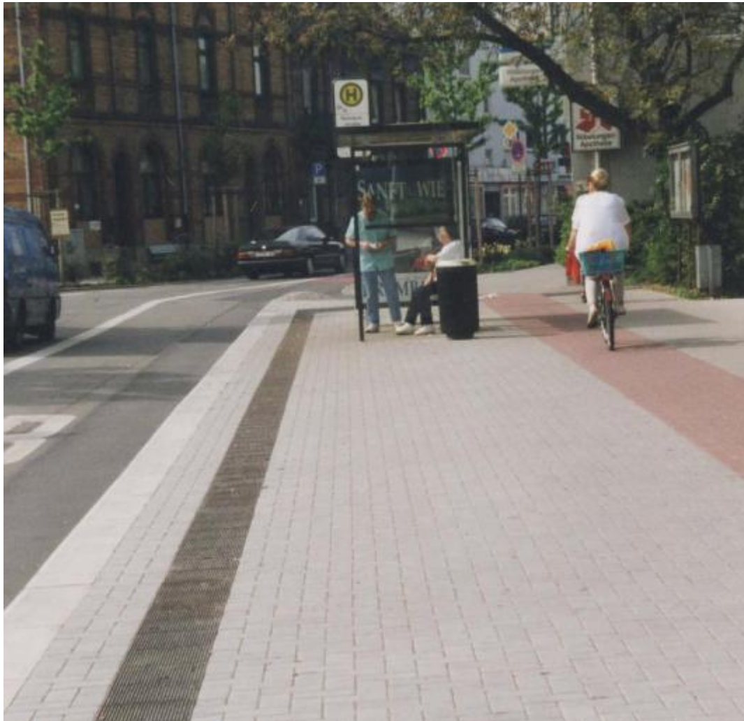
Abb. 27: Bodenmarkierungen Bushaltestelle Rohrlachstraße
