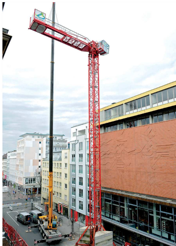
Foto: Die Sanierung der Außenhülle im Jahr 2014
