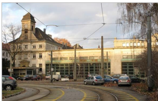
Straßenbahndepot, Bestand 2012 Quelle: Stadt Ludwigshafen
