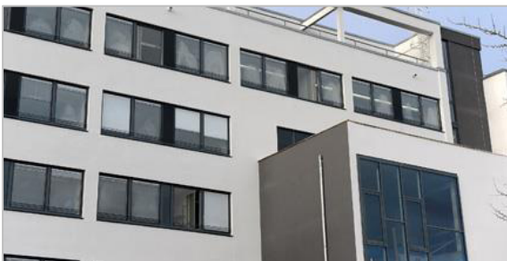
Stadtbibliothek – neue Rückfassade mit Treppenhaus Quelle: Stadt Ludwigshafen
