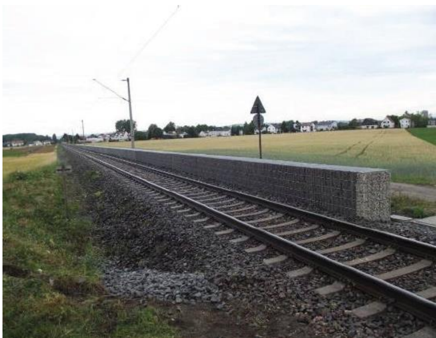
Abbildung 11: Niedrige Lärmschutzwand (Lärmschutzgabionen) Zufahrt KVT
