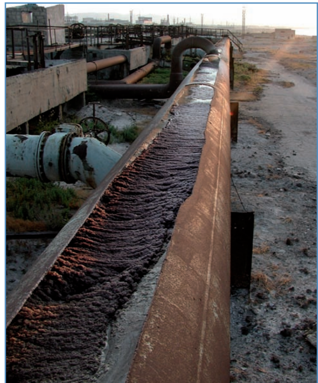
Veraltete Kläranlage in Sumgait
