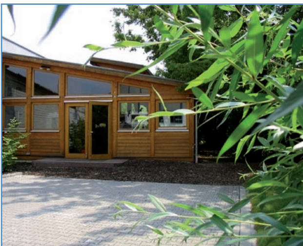
Das Freilandklassenzimmer am Müllheizkraftwerk
