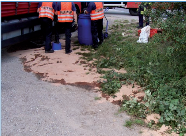
Sicherung und Aufnahme ausgetretener wassergefährdender Flüssigkeit mittels Bindemittel
