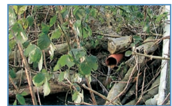
Einleitung von Niederschlagswasser in einen Graben
