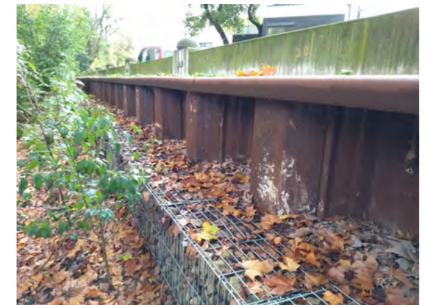
Hochwasserschutzlinie Parkstraße mit Stahlspundwand (2015) und Freibordschutz (alt) aus Stahlbeton-elementen (Foto: Bereich Umwelt)
