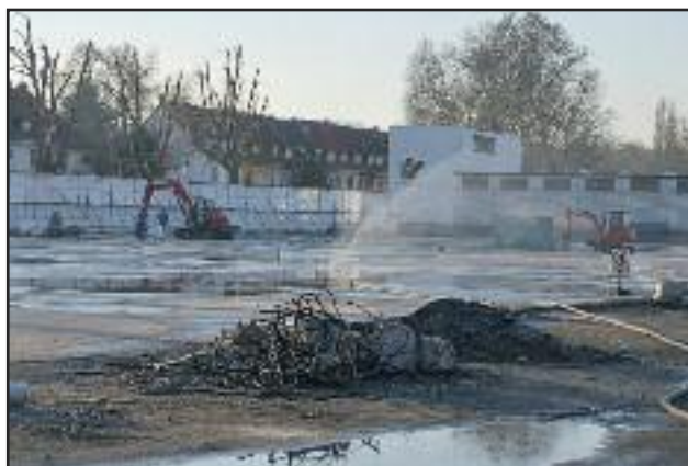
Brandstelle nach Abschluss der Rückbau-, Entsorgungs- und Sanierungsarbeiten
