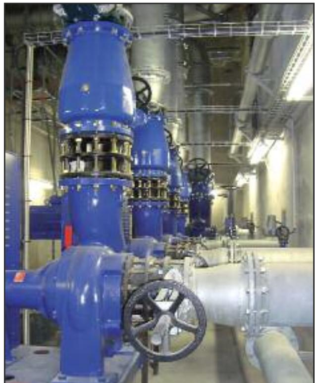
Wenn es wie aus Kübeln schüttet, im Einsatz: Regenwasserpumpen im Pumpwerk Froeschlache
