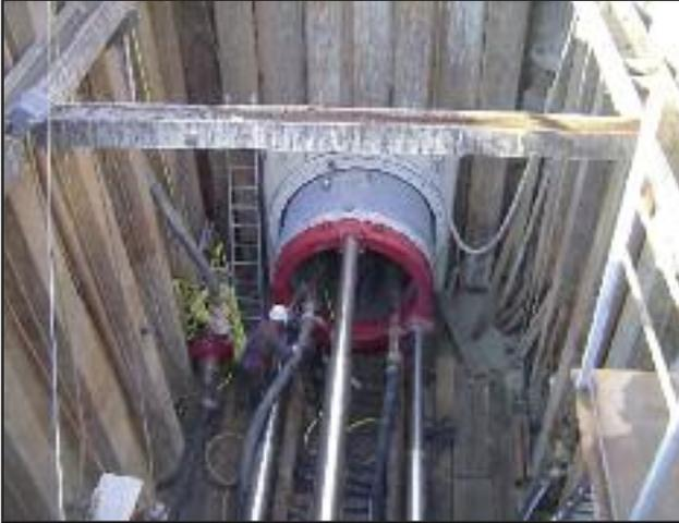
Kanalverlegung im unterirdischen Rohrvortrieb in Oggersheim
