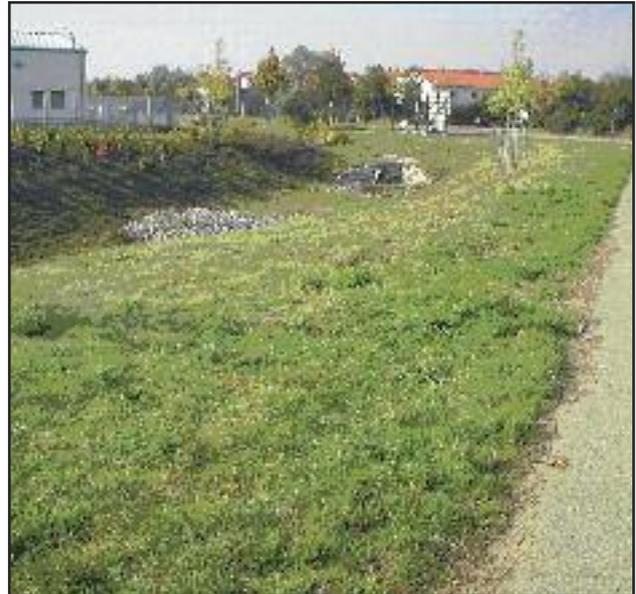
Regenwasser aus dem Trennsystem muss nicht in die Kläranlage: Versickerungsanlage am Unteren Grasweg
