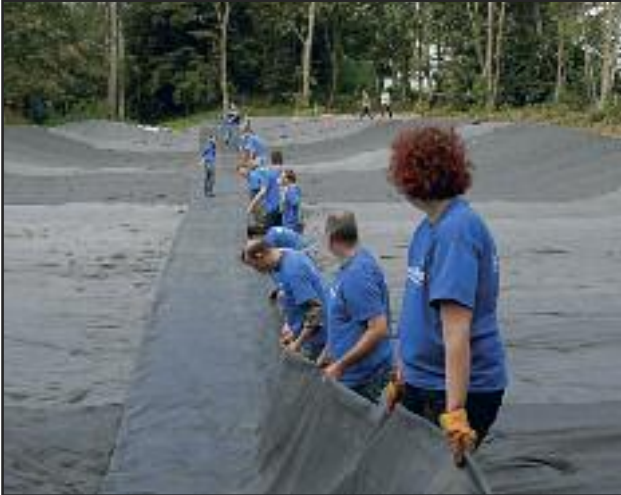
Freiwilligentag 2012: Ein Absetzbecken im Maudacher Bruch wird mit Folie ausgekleidet
