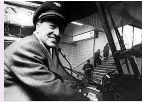
→ Inbetriebnahme der Haltestelle Hemshofstraße 1974
