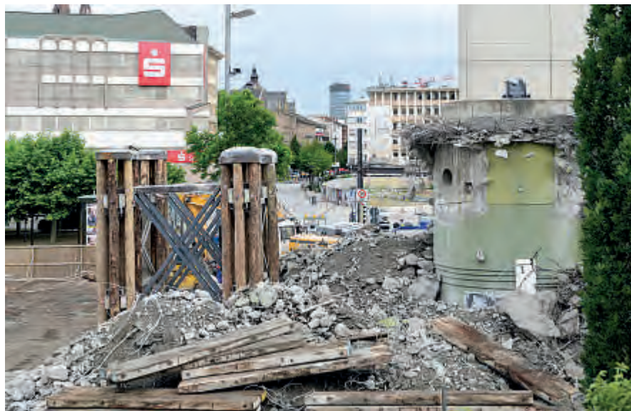
→ Am 14. Juni war der Abriss des ersten Teilstücks geschafft.
