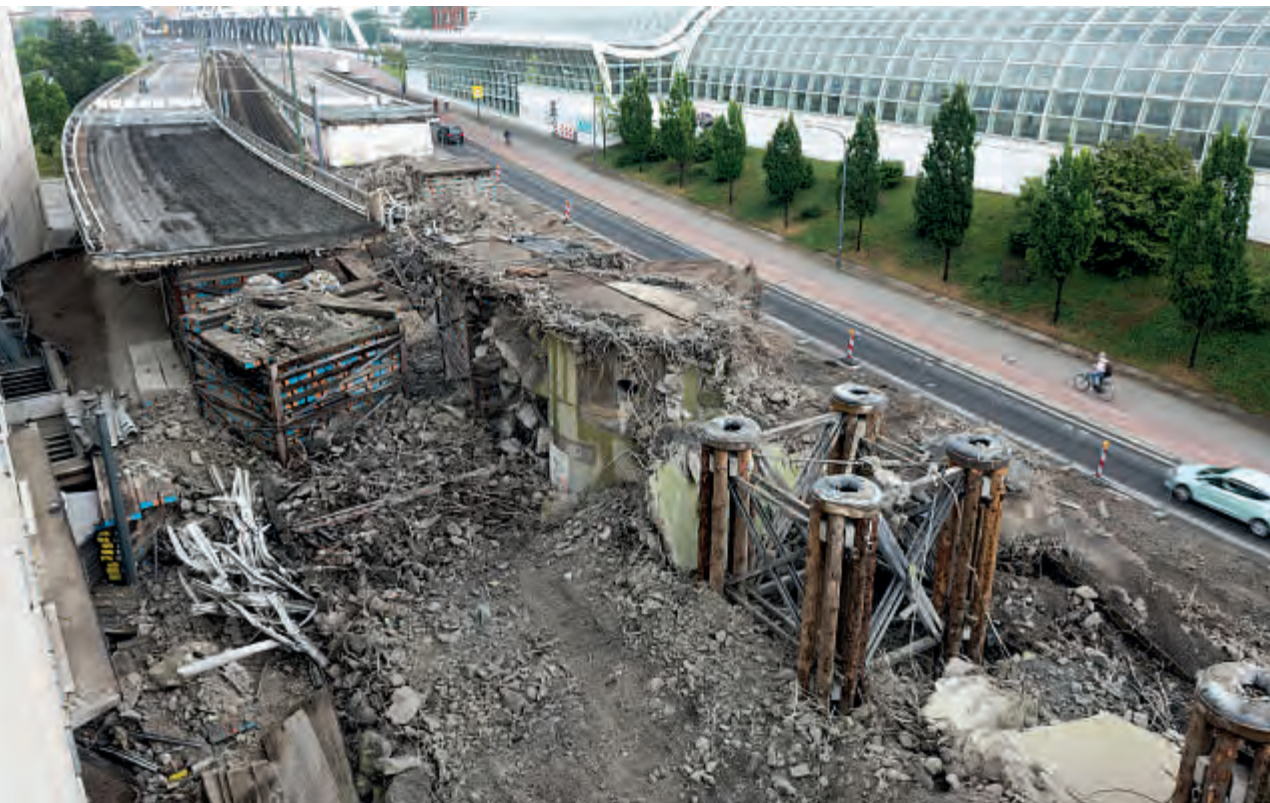
→ Der Abriss des ersten Teilstücks verlief zügig nach Plan.
